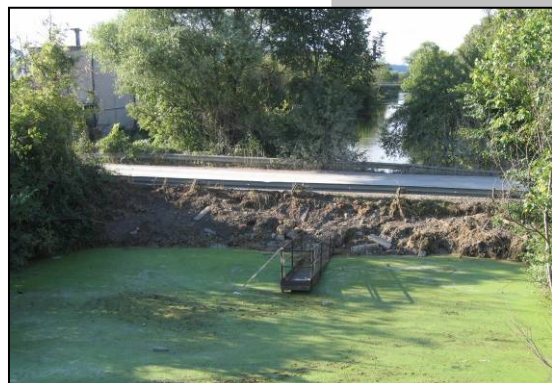
L'ancien canal de dérivation a été rendu inutilisable suite à son recouvrement pour permettre sa traversée.
