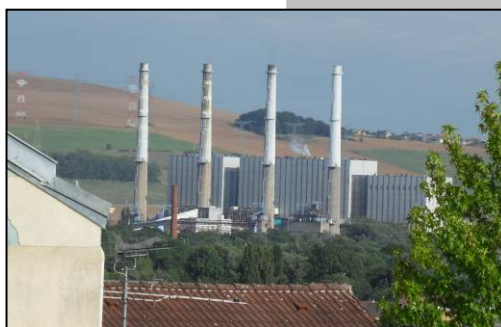
Cheminées de la centrale, vue depuis la rue de France.
