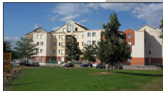
Immeuble collectif, avenue de la Petite Suisse.
