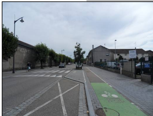
Limitation de l'impact visuel de l'usine,
